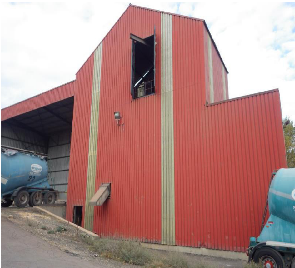
Photographie 2 : Vue du bâtiment – date : 8.11.2017
