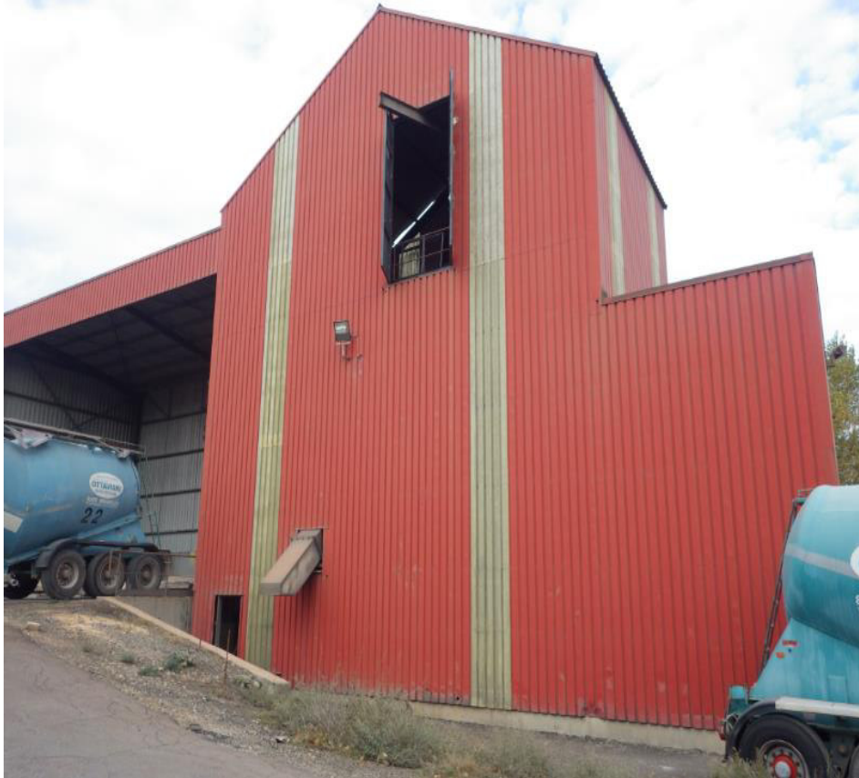
Figure 2 : Vue du bâtiment (existant) – date 8.11.2017
