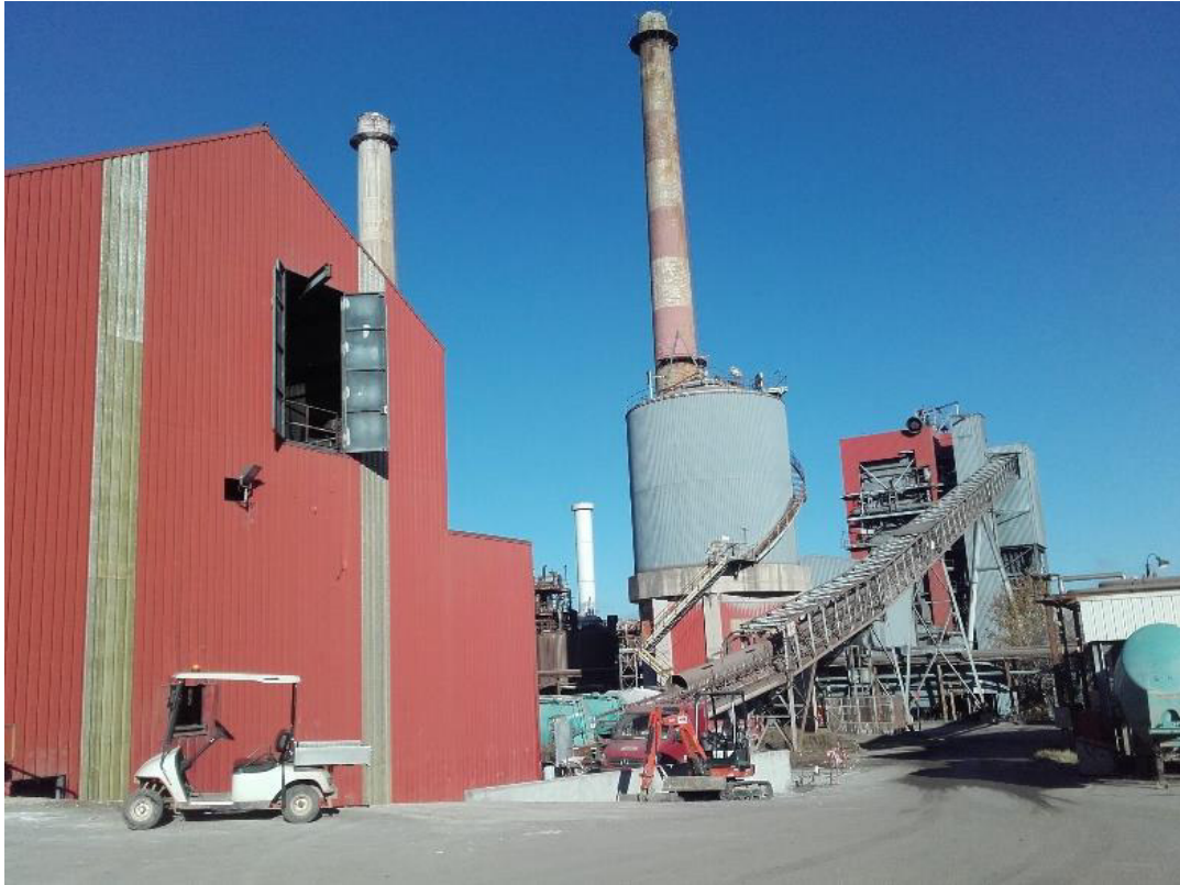
Photographie 1 : Vue du bâtiment dans son environnement -date : 7.12.2018
